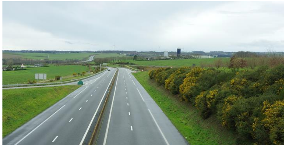
Figure 47 : La N164 et ses talus limitant les vues depuis les franges de Loudéac (Vu d'ici, 2020)
